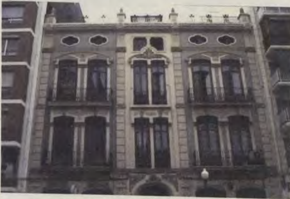
Fig. 7. VICENTE ALCAÿNE: Edificio de viviendas Calle de la Reina, 61. El Cabanyal, Valencia De hacia 1904 (Foto Archivo Javier Delicado)
