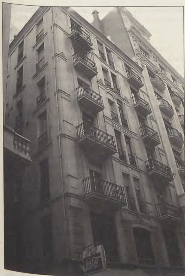
Fig. 14. VICENTE ALCAYNE: Edificio de viviendas Calle En Llop, 3. Valencia. De hacia 1912 (Foto Archivo Javier Delicado)
