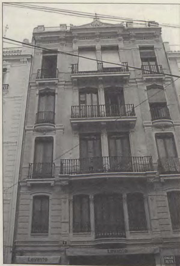
Fig. 10. VICENTE ALCAÿNE: Edificio de viviendas. Calle Alta, 1. Valencia. De hacia 1905. (Foto Archivo Javier Delicado)
